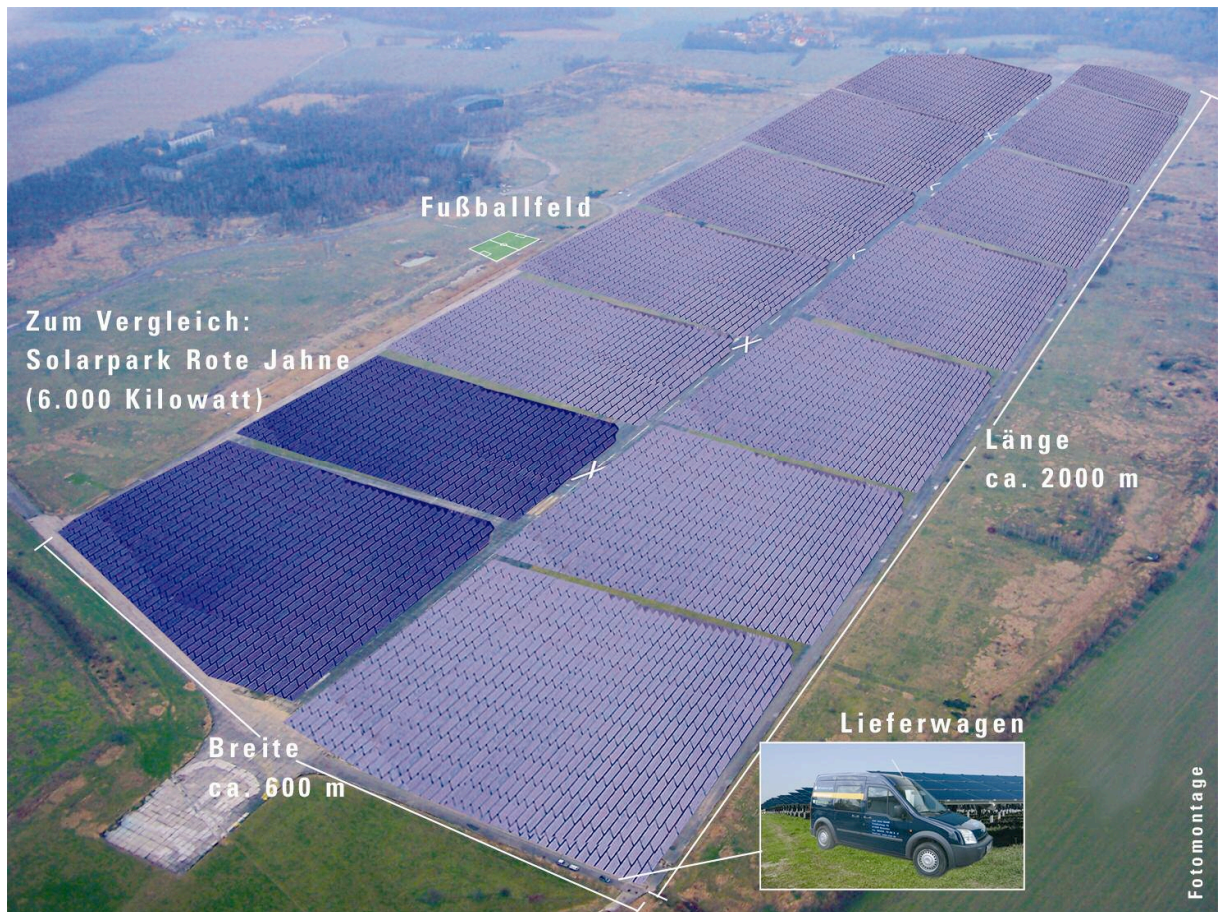
Modulfeld des Solarparks Waldpolenz (40 MW)
