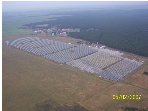
Luftbild der Anlage mit Dünnschichtmodulen
