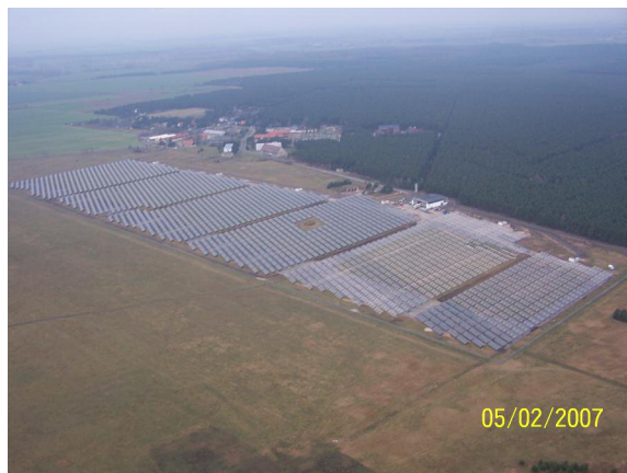
Luftbild der Anlage mit Dünnschichtmodulen
